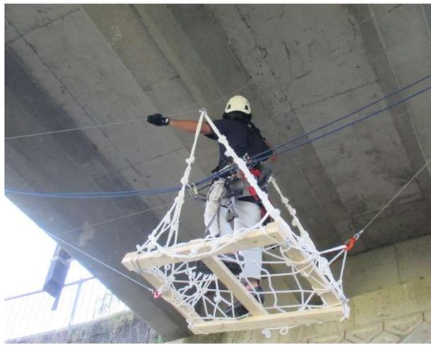
交通渋滞を招く橋梁点検車を使用せず、大規模な吊足場も設置しない、点検員とロープ、ワイヤーに吊り籠だけの、シンプルかつ橋梁管理者や通行車両、通行者にも都合の良い画期的な方式です。
